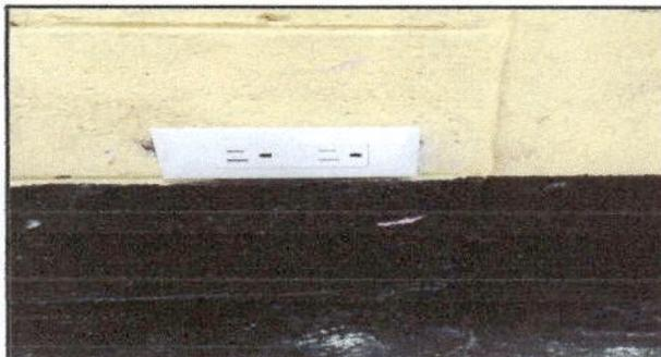
Foto 9: Se muestran los tomacorrientes que se instalaron en todos los módulos.
