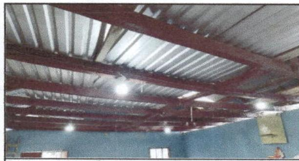
Foto 6: en esta fotografía se muestra los focos ahorradores que se colocaron en todos los módulos.
