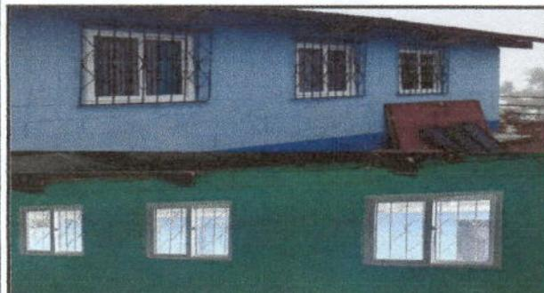
Foto 3: Se muestran fotos de las ventanas de pvc ya instaladas.
