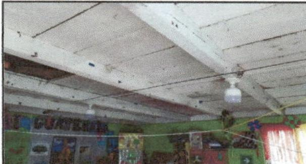
Foto 7: se muestra las plafoneras que se instalaron en todos los módulos.
